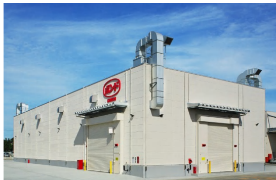
（今期新設）危険物倉庫 800パレット収納
